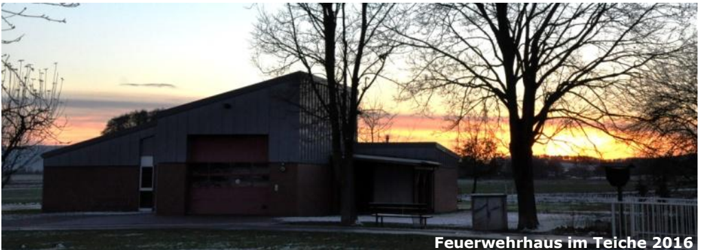
Feuerwehrhaus im Teiche 2016
